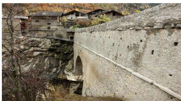
et se présente, en effet, construit sur deux niveaux: une canalisation supérieure imperméabilisée pour l'écoulement de l'eau et un passage dans la partie inférieure, d'environ 1 mètre de largeur, qui permettait le transit d'hommes et animaux.
